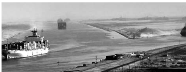
図1 スエズ運河 (Ballahバイパス付近) 出典:スエズ運河庁HP
